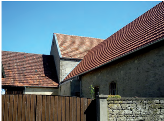
Ruhige, ungestörte Dachflächen
