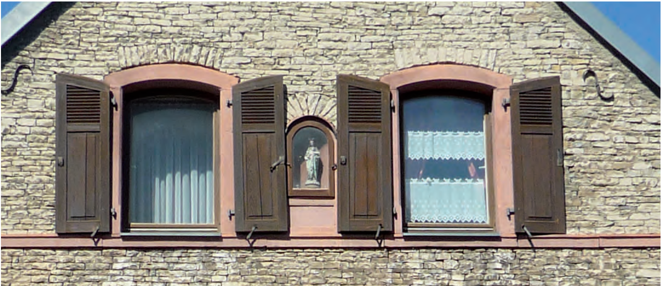
Fenster mit Sandsteingewände und Klappläden
