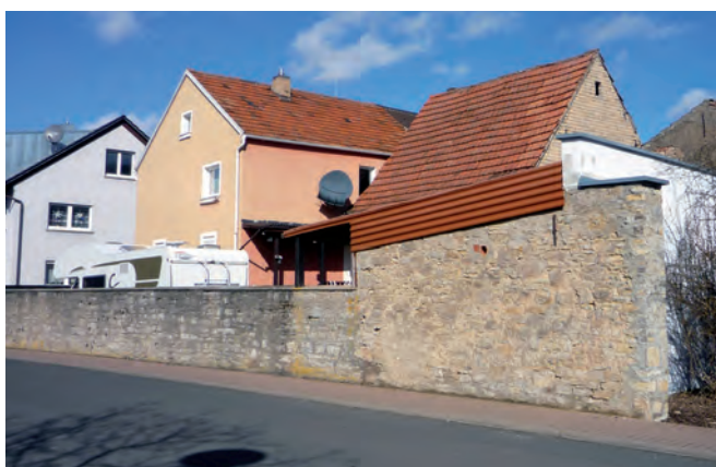
Natursteinmauer als Hofabschluss
