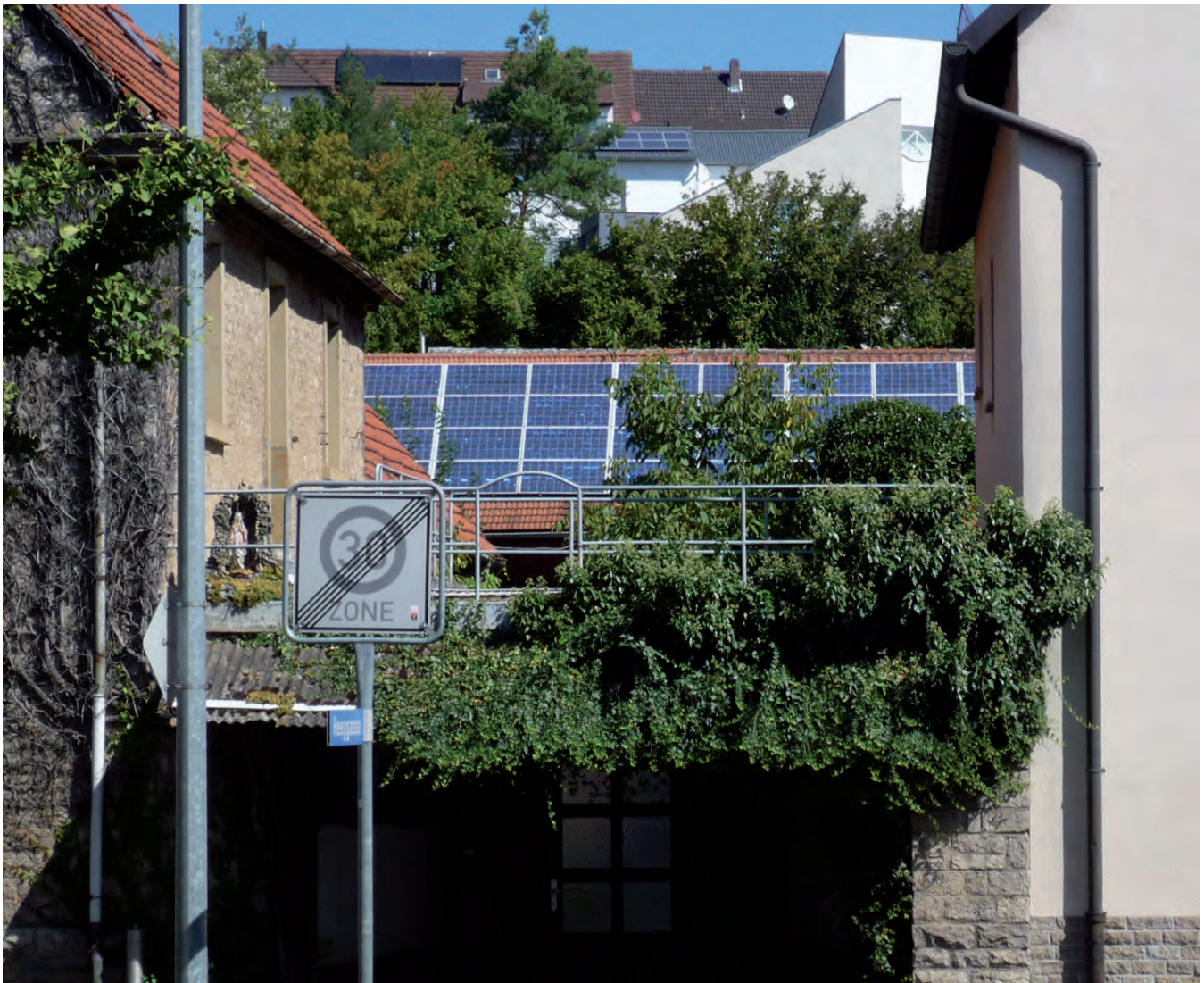
Photovoltaikanlage in Güntersleben auf zurückgesetzter Dachfläche (ortsbildverträgliche Lösung)
