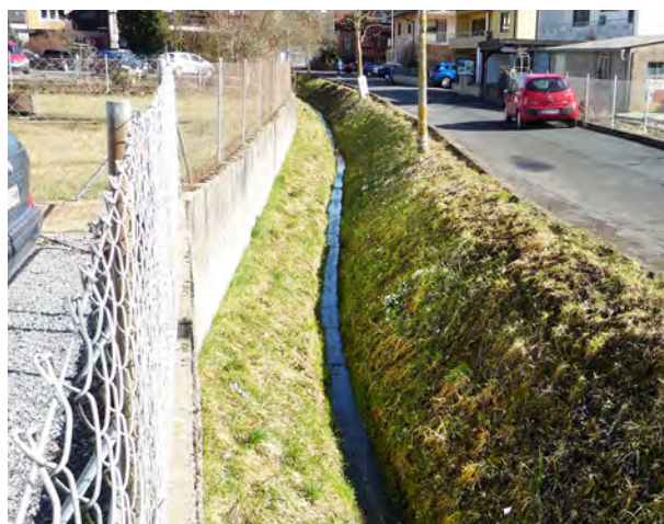
der Dürrbach im Bereich Bachweg
