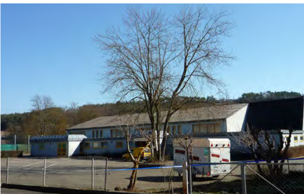
Festhalle mit Sanierungsbedarf
