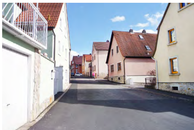
fehlender Gehweg in der Joseph-Weber-Straße
