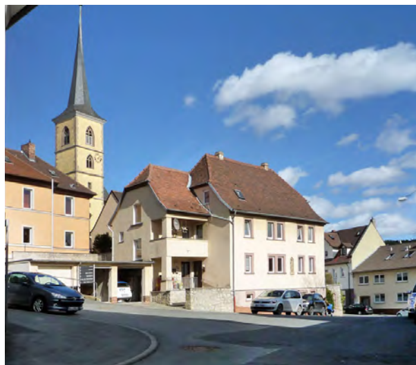
Frühmessnerhaus am Schönbrunnenplatz
