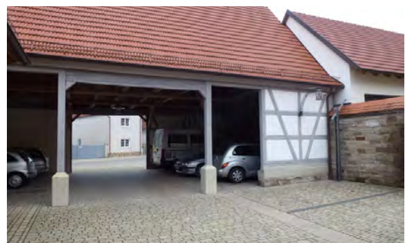
Beispiel Parkscheune in Stadtlauringen
