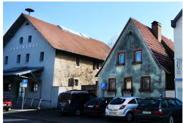
Gebäude rechts des Lagerhauses
