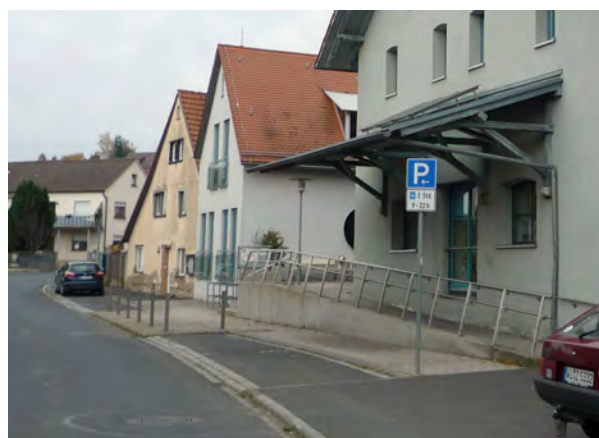
Der Zugang zum Lagerhaus ist bereits barrierefrei, aber im Gebäude besteht noch Umbaubedarf
