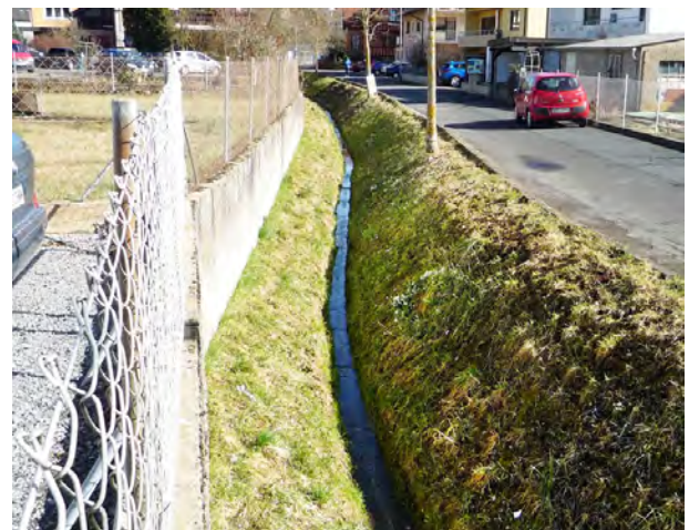
der Dürrbach im Bereich Bachweg
