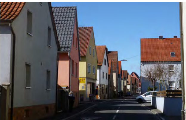
typische giebelständige Bebauung in der Thüngersheimer Straße
