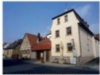
Farblich einheitliche Fassadengestaltung des Bürgerhauses
