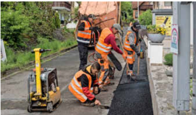
Glasfaserverlegung im Bachweg – Die Gräben werden wieder asphaltiert.
