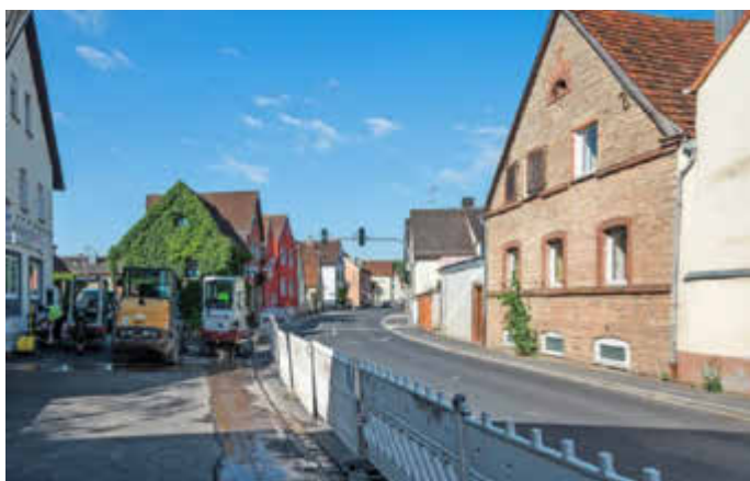
Beendigung der Glasfaserverlegung Lagerhaus
