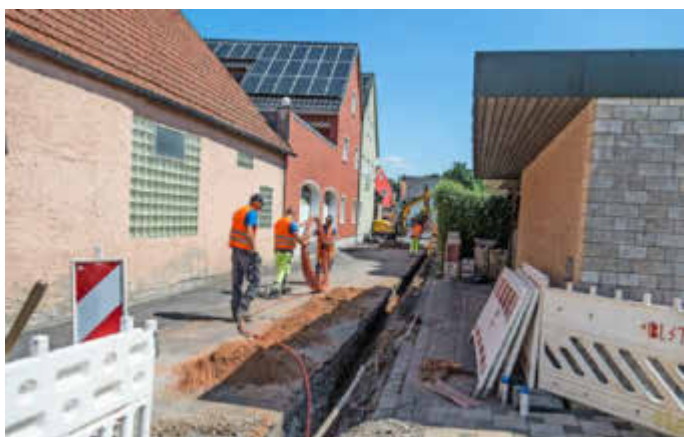
Verlegung der Glasfaserkabel in der Gartenstraße
